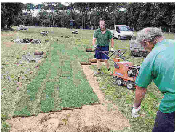
Operai di Alfea lavorano alla rizollatura parziale della pista grande
